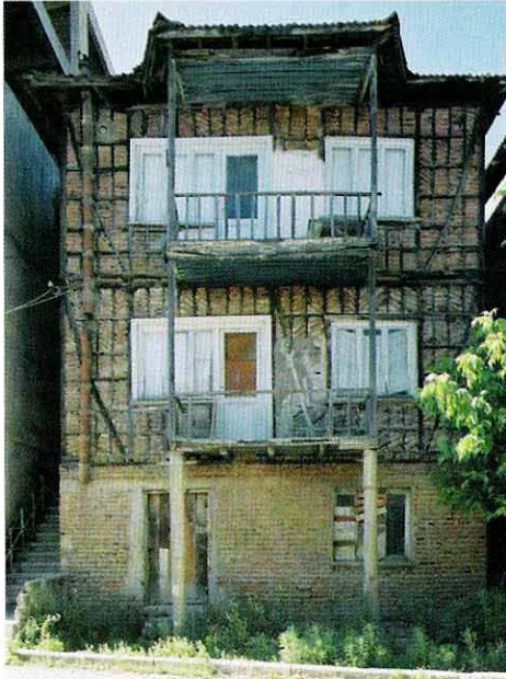
Gölcük depremde ayakta kalan ahşap karkaslı bir yapı.
