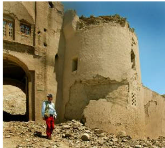
Figura 15. Una delle poche torri sopravvissute ha una camera alla base come mostrato dalla finestra a pianterreno. Il piano con travi in legno incassate nella muratura, ed ora messe in luce dalla caduta dell'intonaco. Le mura e lo stucco venuti giù sembra che siano modifiche moderne della forma della torre nella maniera di Viollet-le-Duc. La superficie originale della torre che vi sta dietro è intatta.
