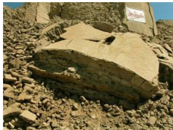
Figura 22. La sezione crollata della porta principale mostra l'alloggio di legname di rinforzo in pareti realizzate con la tecnica khesht .
