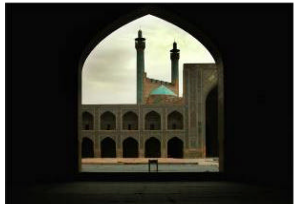
Figura 21. La moschea dell'Imam a Isfahan, aprile 2004. Il nucleo interno di molte delle sue mura e quelli degli altri grandi monumenti della città sono composti da argilla cruda.
