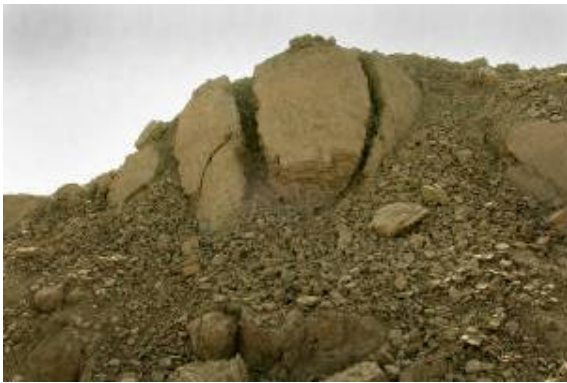
Figura 16. Torre circolare crollata sui bastioni che mostra i segni dello scoppio per il collasso degli strati interni.
