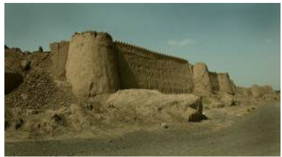
Figura 18. Bastioni settentrionali che erano significativamente meno danneggiati dal terremoto rispetto alle altre mura della città. Si noti che la merlatura è ancora intatta in questo unico braccio, il solo che venne osservato essere in decadenza.
