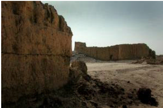
Figura 3. Antiche strutture in terra non restaurate che includono il muro dello Shahr-bast in lontananza dopo il terremoto. Questi organismi erano solo leggermente danneggiati.
