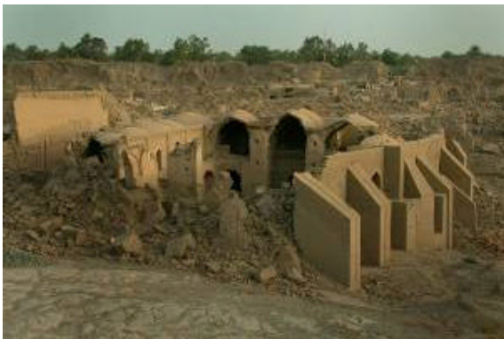
Figura 19. Le rovine del Caravanserraglio mostrano che le camere cupolate al secondo piano dietro ai contrafforti erano venute giù, non quelle sull'altro lato. Non ci sono speroni nella parte esterna del lato opposto. La base del quinto contrafforte si è schiacciata.
