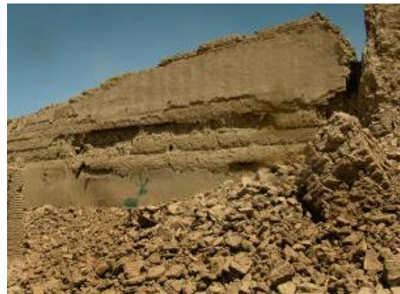
Figura 24. La veduta esterna delle mura meridionali del cortile delle stalle mostra come la stratificazione dei massoni ha interrotto la propagazione delle fessure e del collasso di settori di muratura, aiutando a mantenere la stabilità della parte poco definita della parete in alto.
