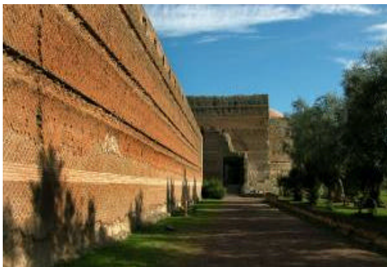
Figura 25. La lunga parete del Pecile a Villa Adriana vicino Roma mostra le fasce di laterizi che erano stese in una muratura realizzata in cemento. Le fessure sono il risultato di un'asportazione successiva per il riuso dei laterizi.
