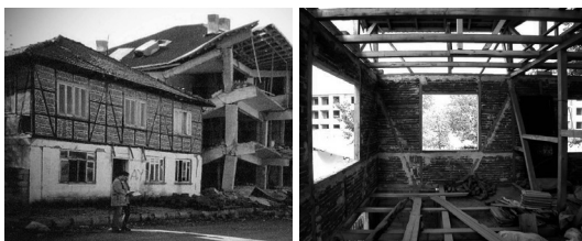
Fig. 8. Hımış next to collapsed RC (by ©Adem Doğanün) (l), and new hımış house in Duzce (r).
